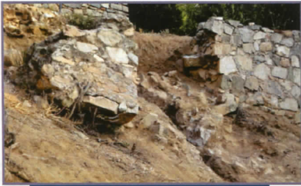
Parets de les habitacions de la vil·la de Sentromà abans, i després de la restauració.
