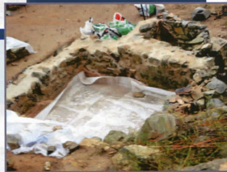
Dipòsits decantadors de vi, abans i després de la restauració i protecció
