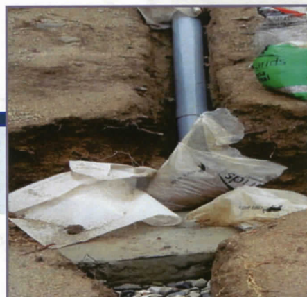
Tubs i rases de protecció del jaciment per desviar les aigües pluvials
